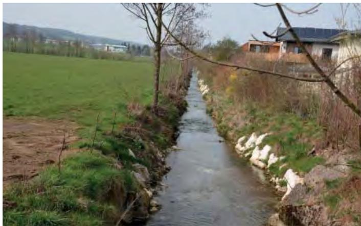
*Im Bereich zwischen Lindenhofstraße und der Reintalstraße wird die Mattig um fünf Meter verbreitert um mehr Volumen zu schaffen und die Fließgeschwindigkeit zu senken. Weiters wird das Bachbett verbreitert, sodass der Bach im Niedrigwasserfall wieder mäandern kann. Flachere Uferböschungen sind auch weniger wartungsintensiv.*
